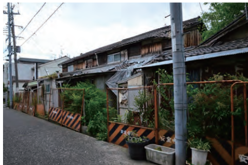
写-1 安全・景観などに悪影響を及ぼす空き家
