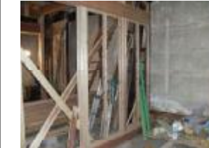
①既存柱・梁の補強及び交換
