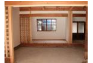
③格子壁・床下・欄間部分の小壁の設置による全体構面補強
