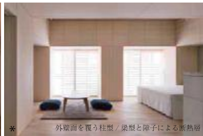
外壁面を覆う柱型/梁型と障子による断熱層
