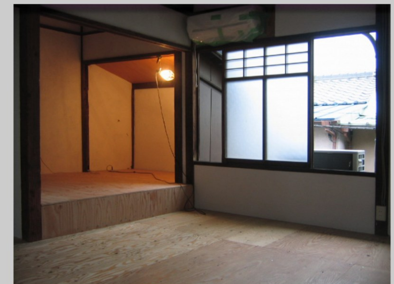
■施工中の写真-5 2階の床材が張り終わった様子。腐食が激しい箇所は新たに下地から組み直し意図的に床に段差を設けた。既存床はどこも激しく歪んでおり、床を仕上げると言うよりもまるで地盤整地作業をしているかのようだ。
