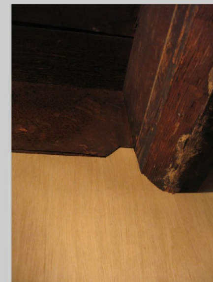
■施工中の写真-4 新設壁（ラワン合板）と既存梁との取合部。既存長屋の真壁意匠を継承するために合板を複雑にカットして納めている。
