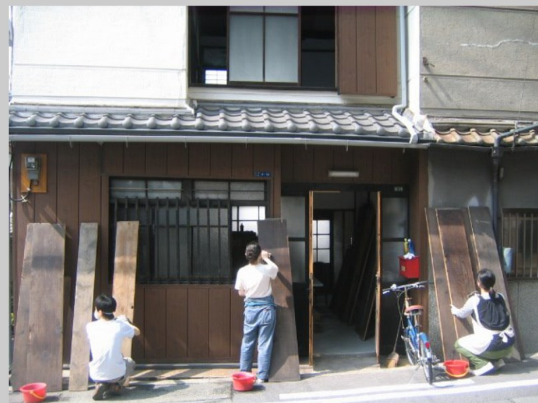
■施工中の写真-2 1階の床に貼るための杉板を丁寧に雑巾がけしている様子。材木屋を通じて上新庄の長屋から解体された古材を購入した。路地で作業していると近隣の方が頻りに声を掛けてくださり、長屋についての会話が弾む。
